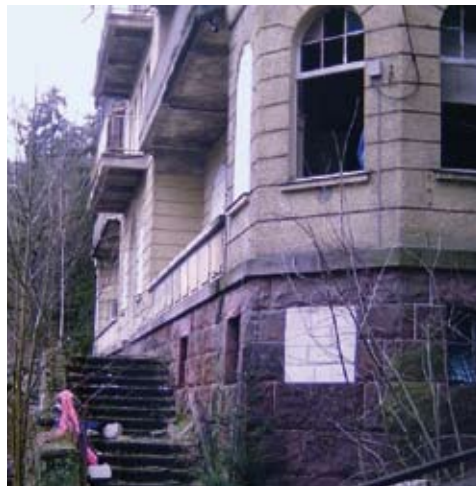
Vor Zumauerung des Obergeschosses
