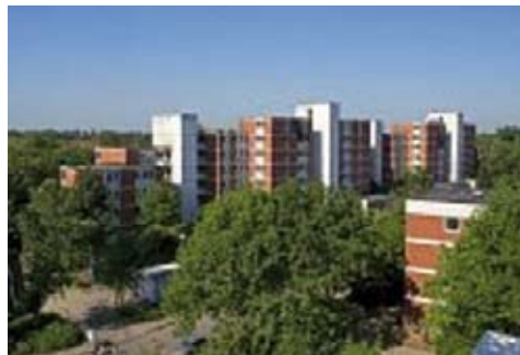
Vor dem Abriss
