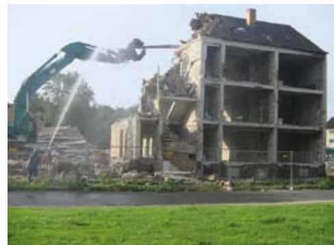
Während des Abrisses
