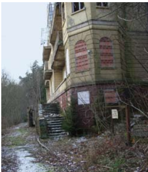
Nach Zumauerung des Obergeschosses
