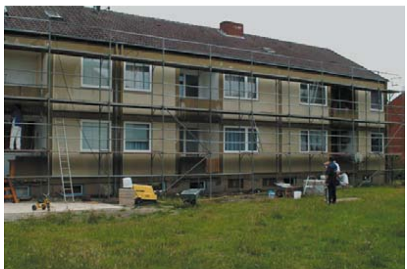
Zustand vor der Sanierung
