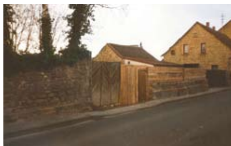
Nach dem Abbruch
