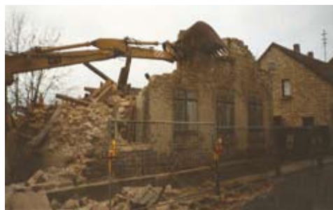
Während des Abbruchs
