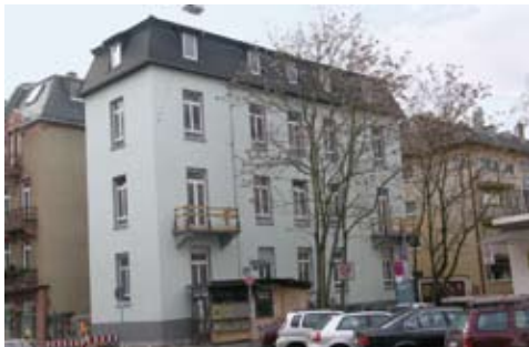
Sanierung des Gebäudes
