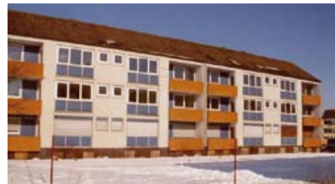
Vor dem Abriss
