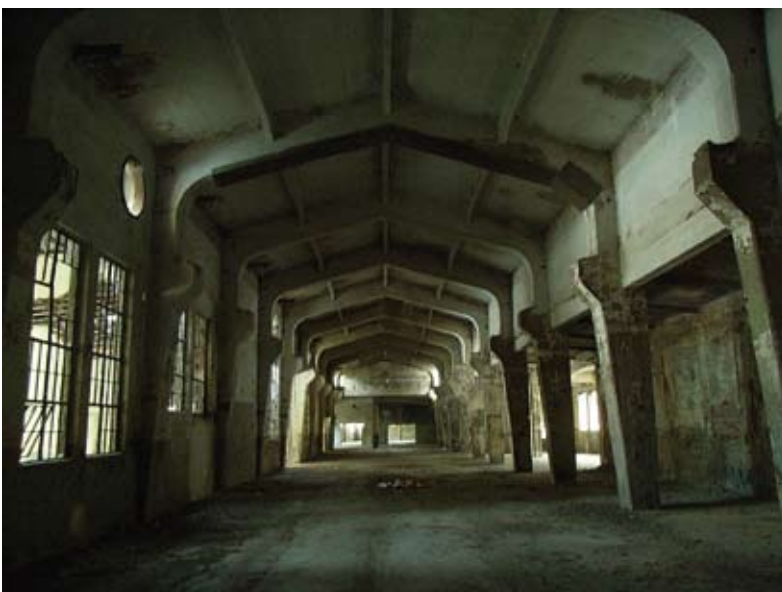
Innenansicht auf Teil des Erdgeschosses
