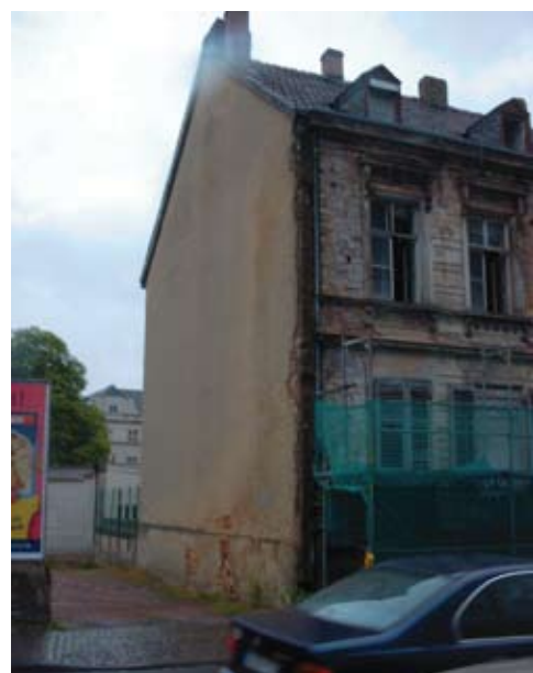
Sicherungsmaßnahmen an der Vorderseite
