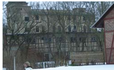
Blick vom Bahnhof Tannroda auf die ehemalige Papierfabrik
